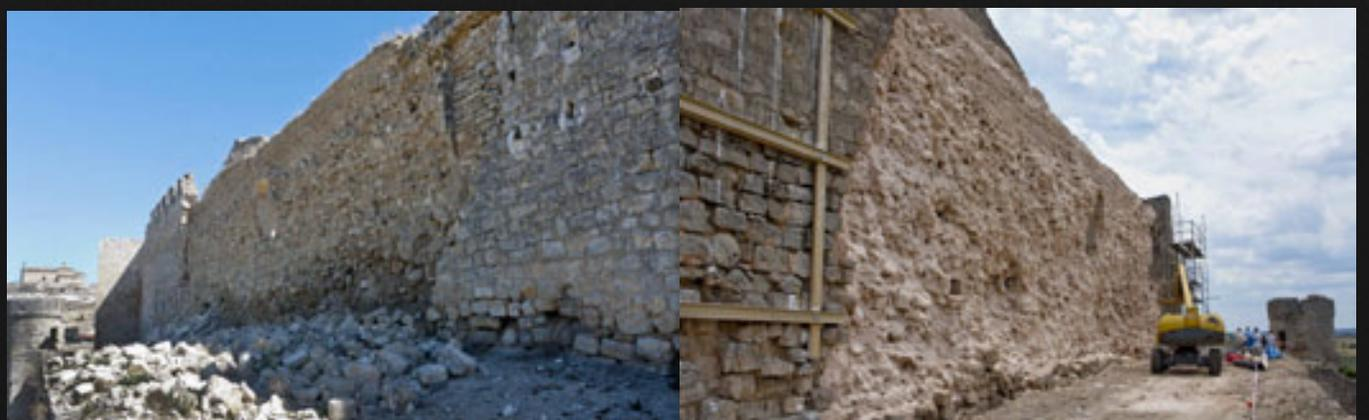
Fotografías del estado de derrumbe de parte del muro. Fuente: Obras son amores... Junta de Castilla y León.
