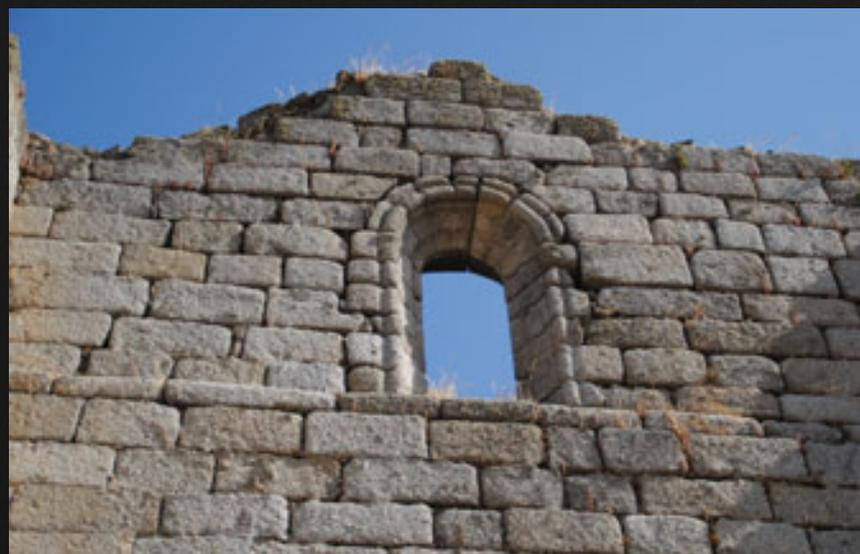
La construcción se realizó en granito con mortero de cal.
